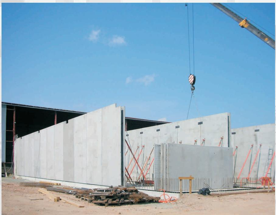
Realizace několikapodlažních tribun systémem železobetonové montované konstrukce je dnes již zcela běžná. V oblasti staveb pro zemědělství beton vždy patřil k nejčastěji používaným materiálům, zejména pro jeho vysokou odolnost proti agresivnímu prostředí bez dalších zvláštních úprav. Novinkou poslední doby je realizace plynотěsných biostanic systémem železobetonových montovaných sekcí se zastropením.
