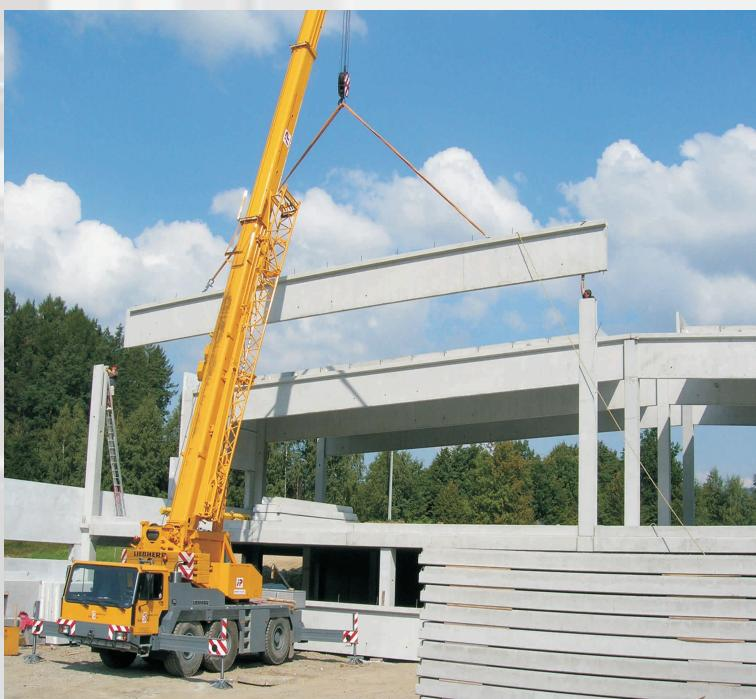
Vlastními zaměstnanci je prováděna montáž železobetonových konstrukcí i realizace všech typů opláštění od variant skládaných na stavbě až po střešní a obvodové pláště prováděné z kompletizovaných panelů firem Kingspan, Trimo aj. Montáž konstrukce zpravidla završuje etapu dodávky nosného systému a rozhodujícím způsobem ovlivňuje výsledný dojem celého díla. Výběru pracovníků je proto věnována velká pozornost stejně jako volbě vhodných mechanizačních prostředků.
