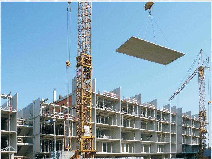
Vícepodlažní stavby jsou nejčastěji používaným konstrukčním systémem pro občanskou a bytovou výstavbu. Jedná se o soustavu vodorovných stropních konstrukcí různého typu doplněnou podporujícími a ztužujícími prvky. Tímto způsobem se realizují bytové domy, školy a nemocnice, stavby občanské vybavenosti, administrativní budovy, bankovní domy a jiné objekty určené převážně pro pobyt osob.
