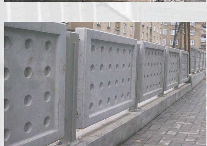
Opláštění budov a oplocení areálů dotváří celkový dojem z montované konstrukce. I pro tyto prvky vystavené účinkům povětrnosti je beton vhodným materiálem ve vztahu k jeho odolnosti proti vlivům prostředí a relativně nízké ekonomické náročnosti. Doplnění stěnových dílců reliéfem nebo firemním logem se pomalu stává standardem.
