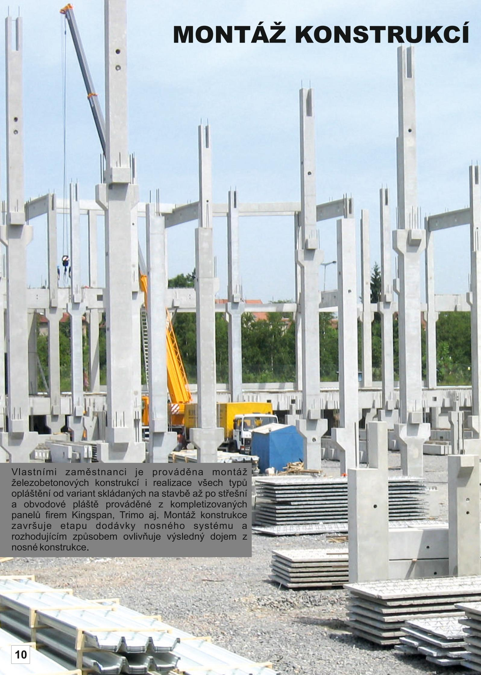
Vlastními zaměstnanci je prováděna montáž železobetonových konstrukcí i realizace všech typů opláštění od variant skládaných na stavbě až po střešní a obvodové pláště prováděné z kompletizovaných panelů firem Kingspan, Trimo aj. Montáž konstrukce završuje etapu dodávky nosného systému a rozhodujícím způsobem ovlivňuje výsledný dojem z nosné konstrukce.
