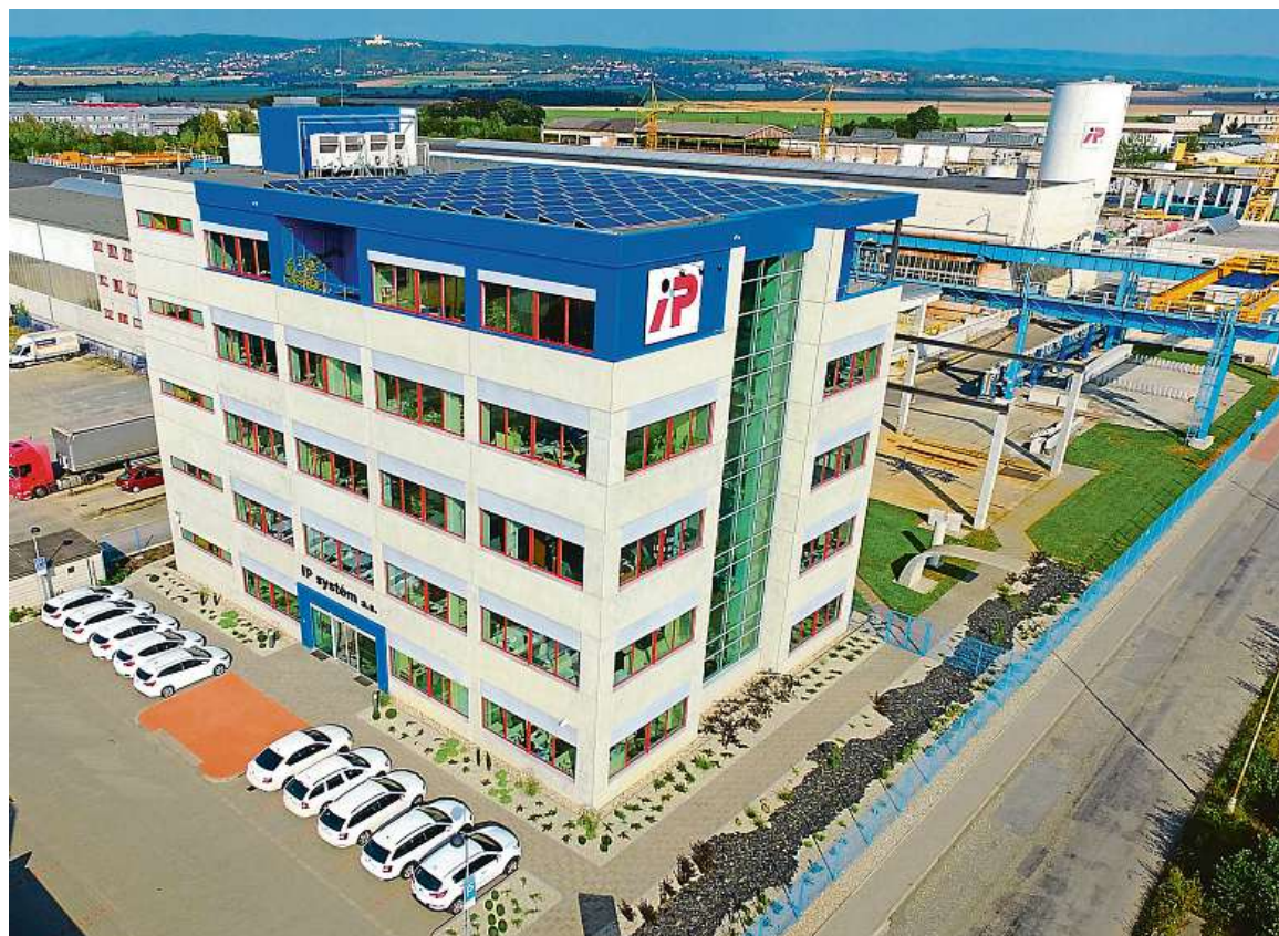
Sídlo Společnost IP systém sídlí v Olomouci v městské části Chválkovice. Nachází se zde administrativní budova i výrobní závod, kde vznikají prefabrikované prvky o hmotnosti až 40 tun. Foto: IP systém
